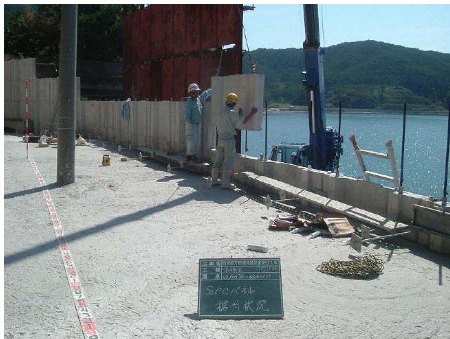
図-5 隠岐災害復旧の工事中写真
