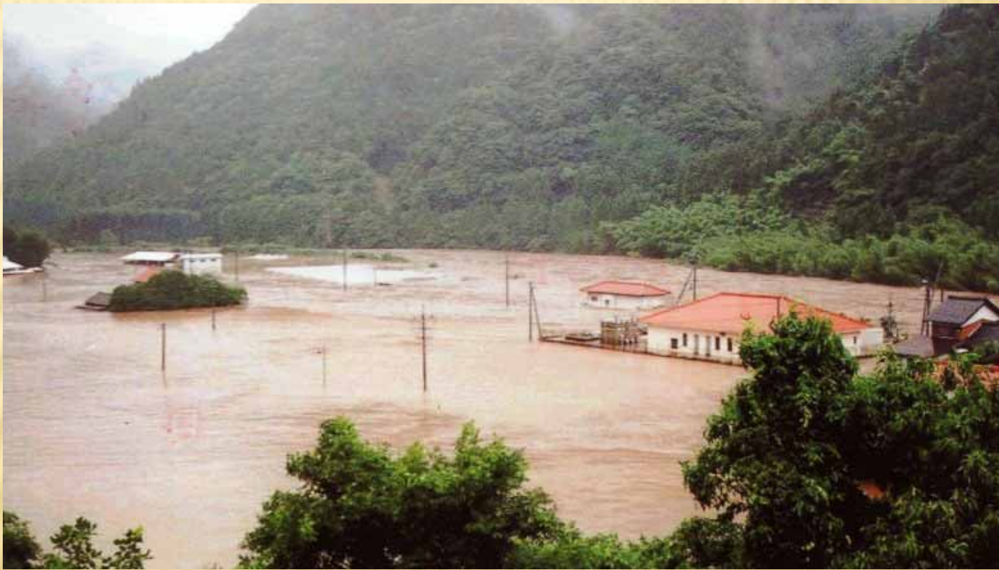
(浸水した乙立浄水場とその周辺)
