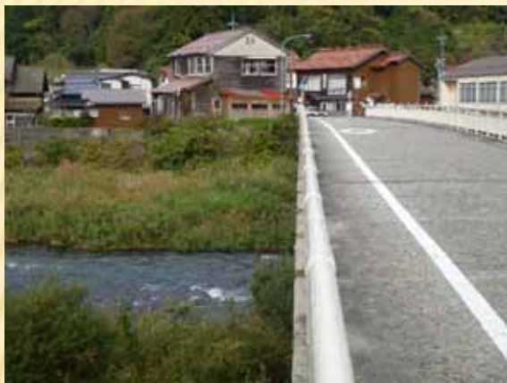
平常時の乙立橋付近
