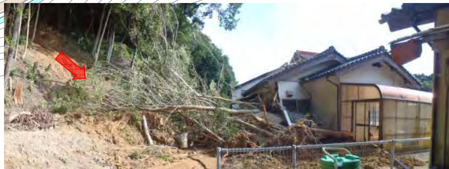
がけ崩れにより被災した人家
