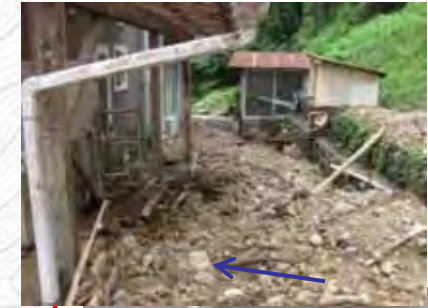
被災状況(人家被害の状況)
