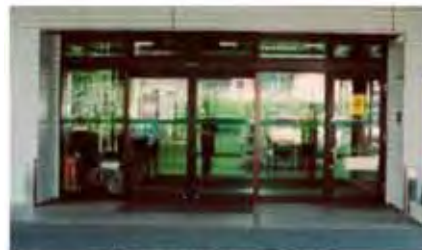
本館玄関への止水板設置状況(設置前) (出典)ヒアリングによる(H21.9.16)
