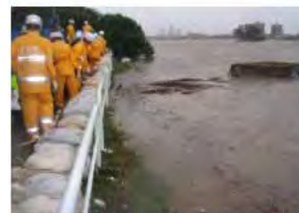
越水に対応するための積土のう工
