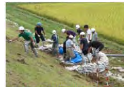
漏水に対応するための月の輪工
