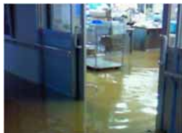
特別養護老人ホーム 幸嶺園の浸水状況 (出典: 山口県 福祉施設等の災害対策取組事例集)
