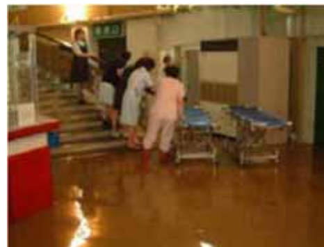
公立豊岡病院の浸水状況 (平成16年10月)
