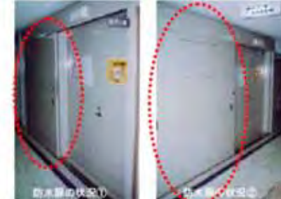
大洲記念病院の浸水対策 (出典: 中央防災会議 大規模水害対策に関する専門調査会報告)
