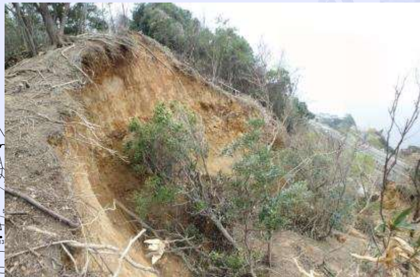
① 頭部滑落崖 最大落差11m
