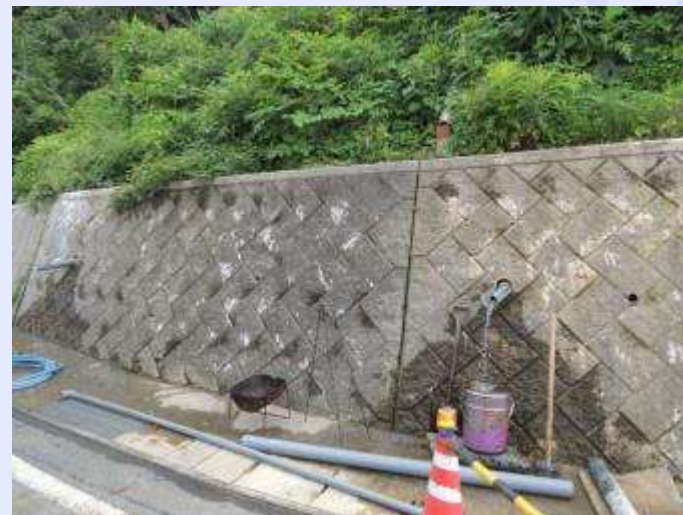
隣接斜面の地下水排除工(別途工事)
