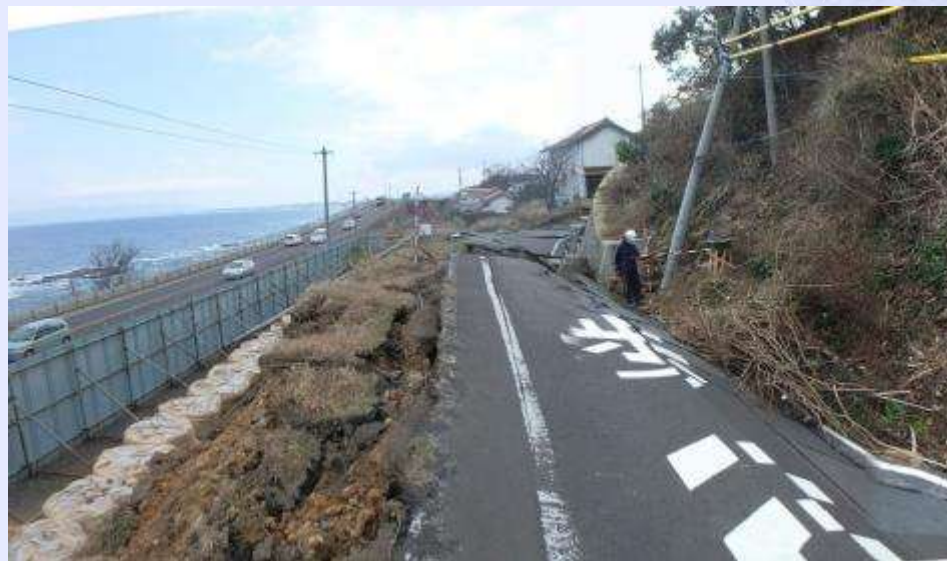
⑦ 大型土のうによる土砂流出防止
