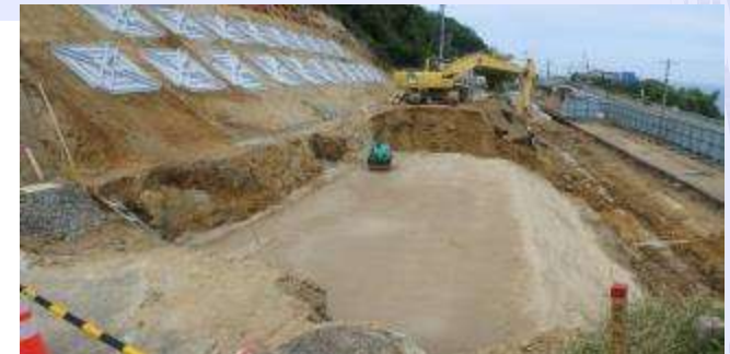
路体部掘削・置換状況(1区間目)
