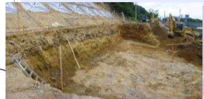
路体部の掘削状況(2区間目)
