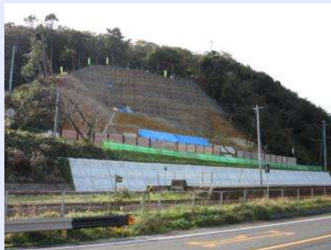
平成28年11月上旬の施工状況
