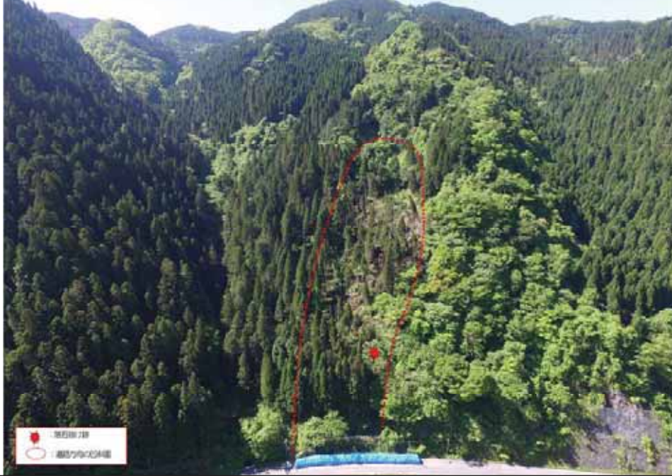
H28.5島根県邑南町における落石斜面
