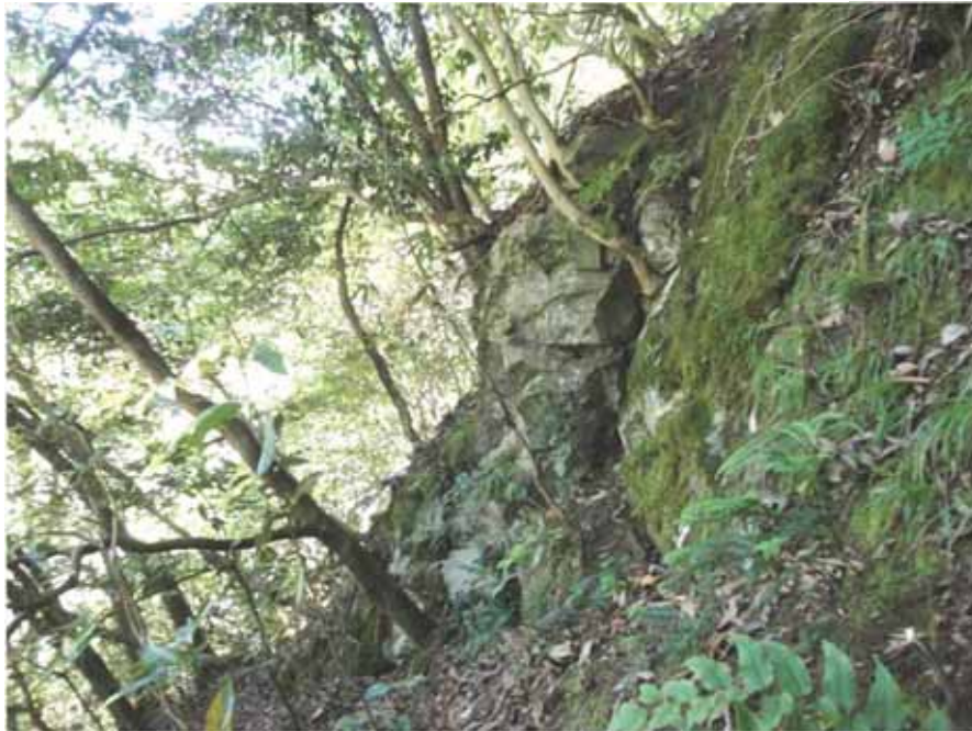
落石斜面と隣接する尾根斜面に巨浮石が露岩する
