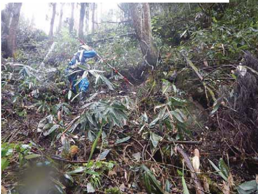
落石発生直後の斜面状況(草本に覆われていた)
