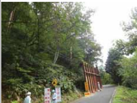
落石危険斜面の緊急対策例 →斜面尻に鋼矢板,落石源に仮設網を設置
