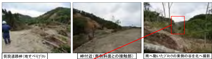
仮設道路峠(地すべりブロック軸部)から上流側を望む 峠付近(黄側斜面との接触部) 南へ動いたブロックの東側の谷を北へ撮影
