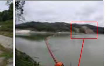
水抜き後のダム湖(11/15)
