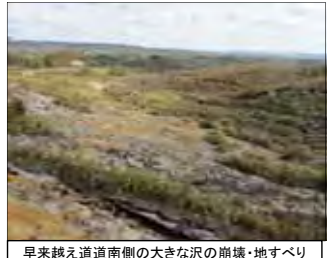
早来越え道道南側の大きな沢の崩壊・地すべり
