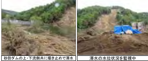
滞水の水位状況を確認中
