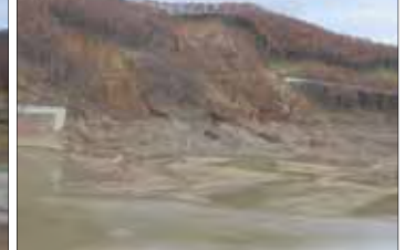
ダム堤に特に異常はないが、ダム湖には所々で崩壊・地すべり体が流入。
