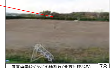
厚真中学校グラウンドの地割れ(北西に延びる)
