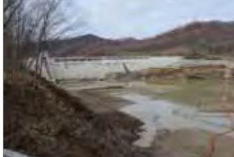
ダム堤に特に異常はないが、ダム湖には所々で崩壊・地すべり体が流入。
