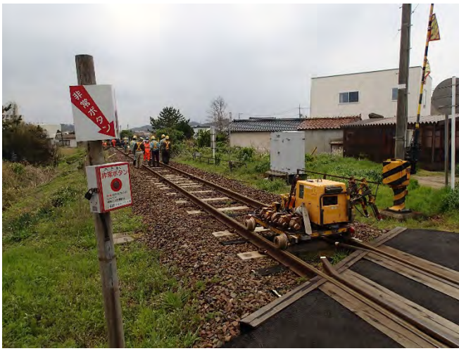
図10. 山陰本線の路盤修繕作業。 山陰本線は区間運休となった。
